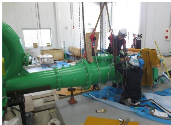
▲配管据付工事
