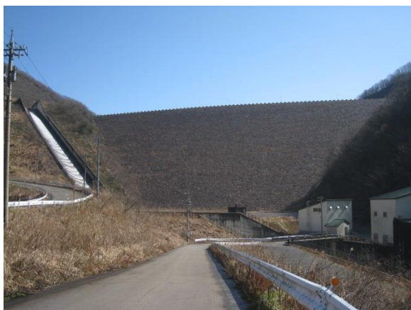
▲ 榎谷ダム（堤体）
