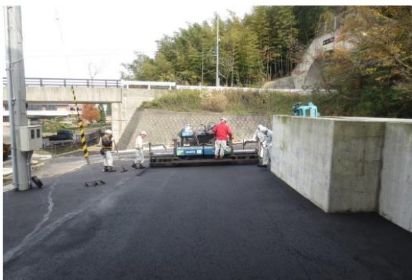
▲付帯工事（舗装工）
