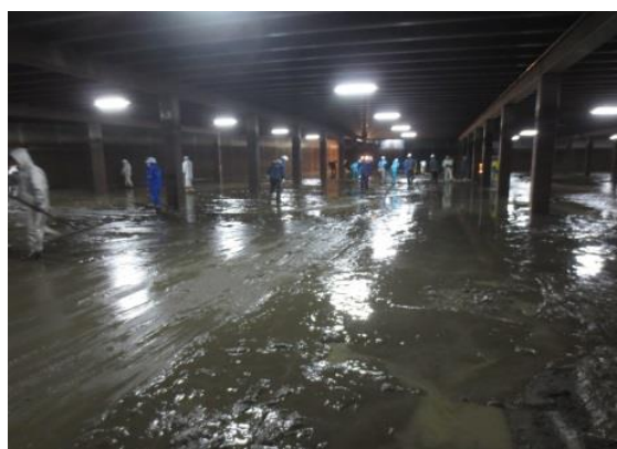
▲ 調整槽排泥作業
