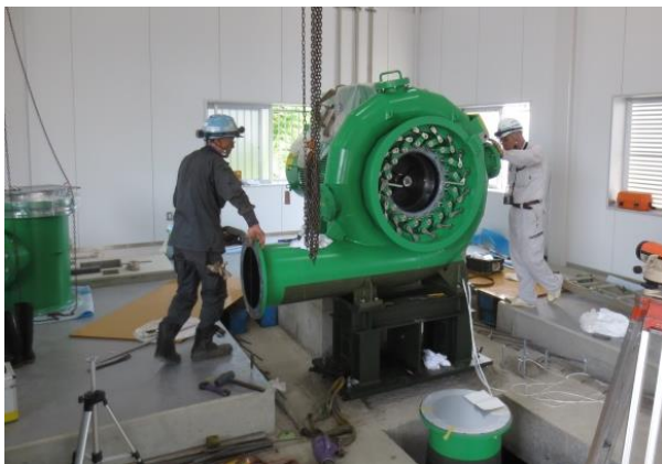
▲水車据付工事
