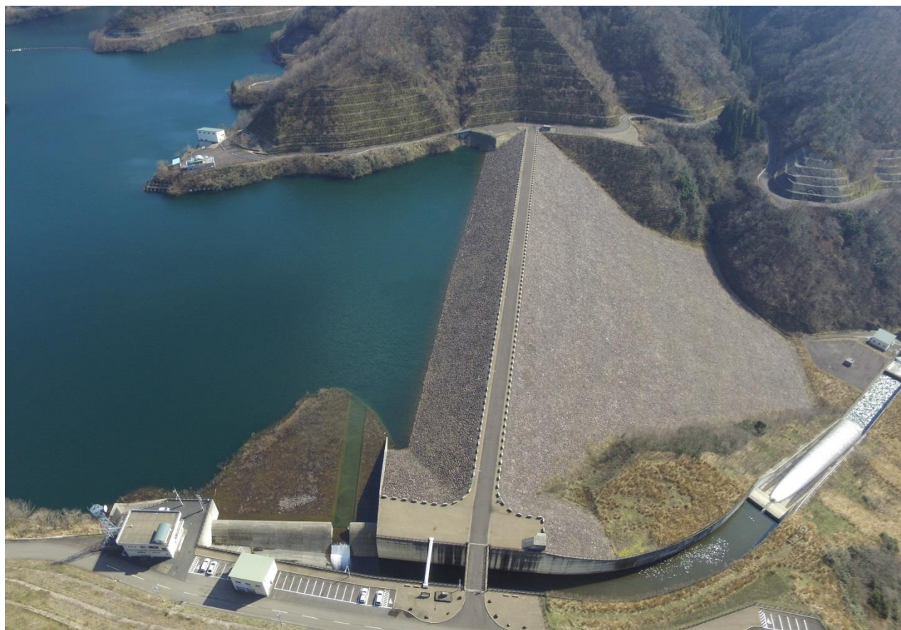
▲柘谷ダム全景（空撮）
