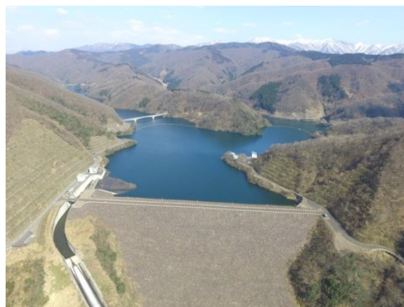
▲ 柵谷ダム（堤体から湖面方向）
