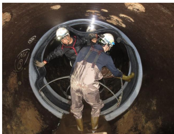
▲内面バンドによるPL補修工事の様子 （中央幹線 FRPM φ1800mm）
