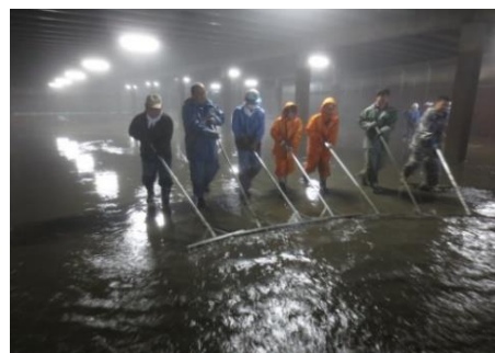
▲調整槽排泥作業
