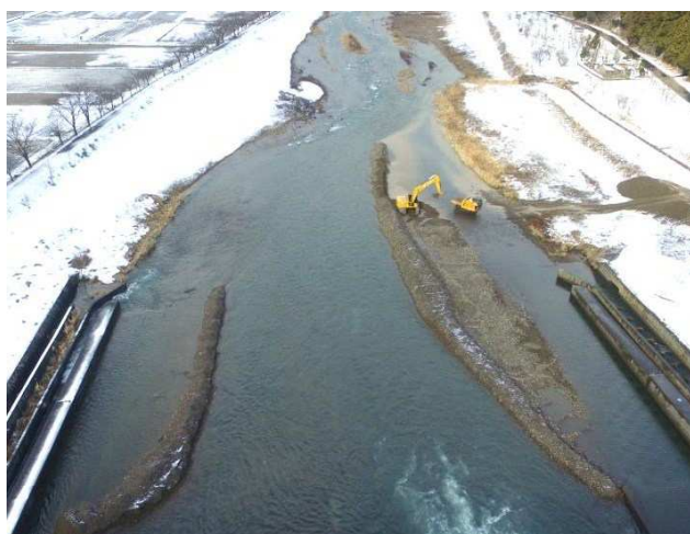
▲堆積土砂撤去工事中（上流から下流方向）
