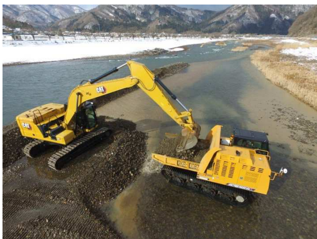
▲土砂積込運搬（近景）
