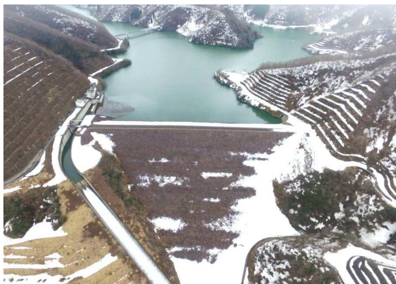
▲柵谷ダム（堤体から湖面方向）R4. 3. 22 撮影
