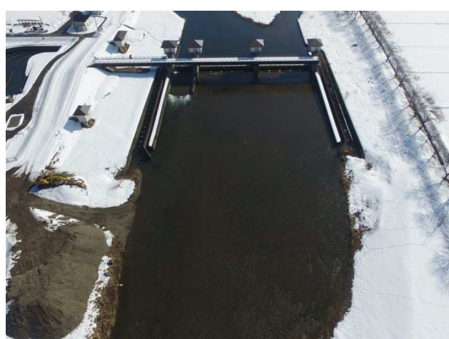
▲下流堆積土砂撤去完了（下流から上流方向）
