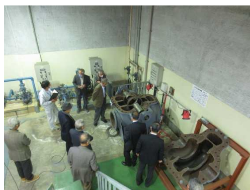
▲坂井北部丘陵揚水機場視察
