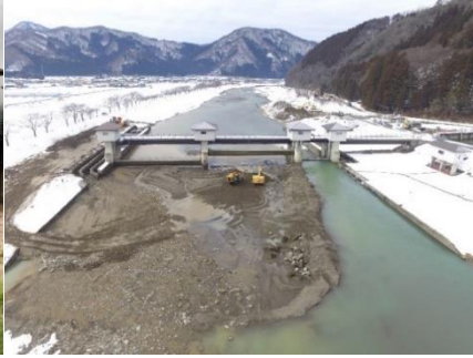
▲堆積土砂撤去工事状況 (上流から下流方向)
