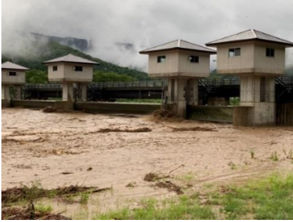
▲取水口付近から下流方向 (R4. 8. 5 撮影)
