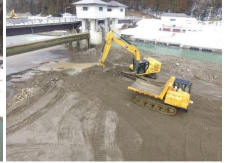
▲土砂積込運搬（近景）
