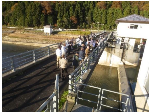
▲八乙女頭首工視察
