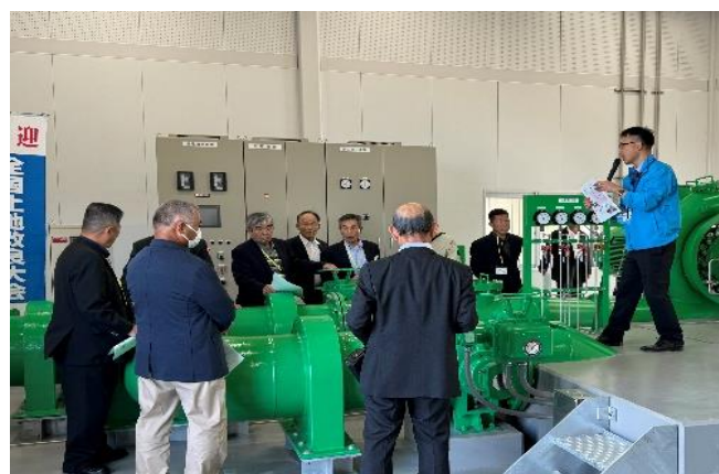
▲日野川用水第2発電所説明状況
