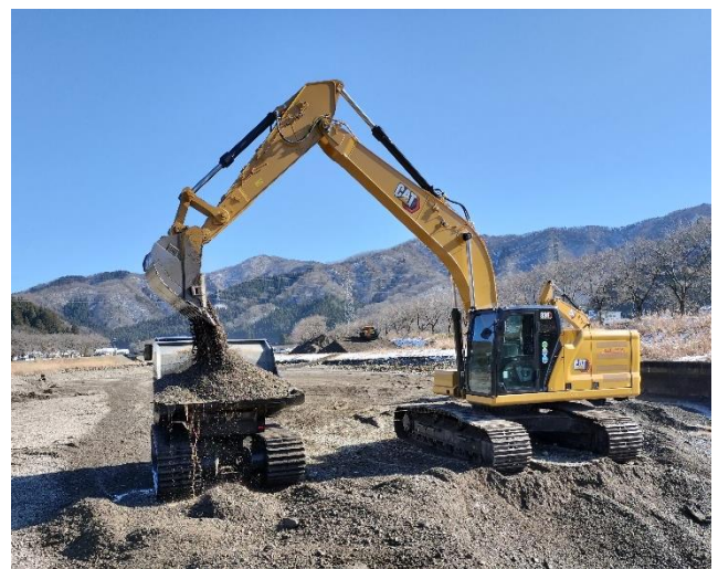
▲堆積土砂積込状況（上流部）
