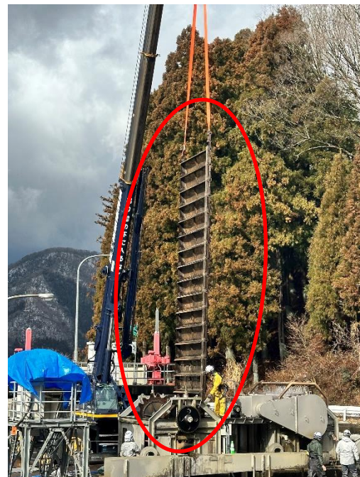
▲既設スクリーン撤去状況
